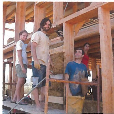
Construcción de un almacén agrícola de balas de paja en Palafrugell (Girona)
